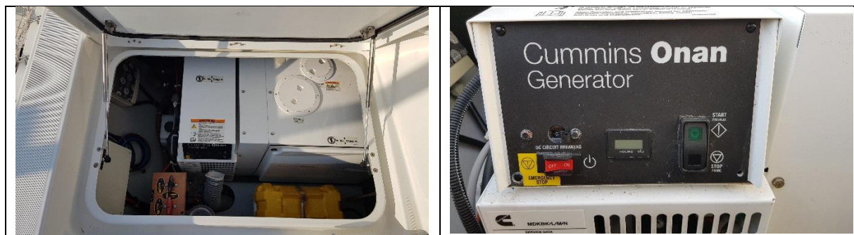
Zdjęcie 37. Po lewej stronie otwarta pokrywa generatora: lewy dolny róg – przełączniki zasilania akumulatorowego i paliwa do generatora, prawy dolny róg – akumulator startowy generatora, lewy górny róg – bezpiecznik generatora). Po prawej stronie - panel sterujący na generatorze.
