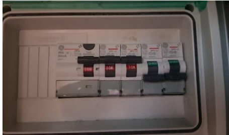
Zdjęcie 25. W szafce w prawej kabinie rufowej bezpieczniki od lewej: w pierwszej puszcze: generator, odsalarka, zmywarka, wolny (opisany jako kostkarka do lodu), w prawej puszcze: różne strefy klimatyzacji. Poniżej puszek (żółty przełącznik) – kabestan elektryczny.
