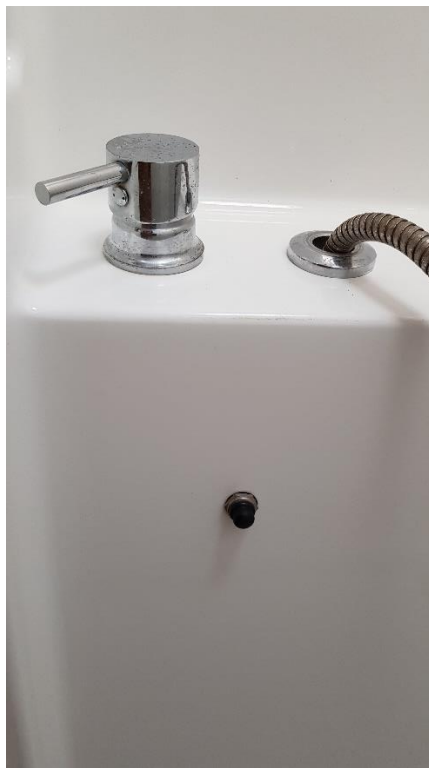
Zdjęcie 32. Kabina prysznicowa, bateria prysznicowa z czarnym przyciskiem do wyciągania wody z brodzika poniżej, oraz zabezpieczone drzwi kabiny prysznicowej
