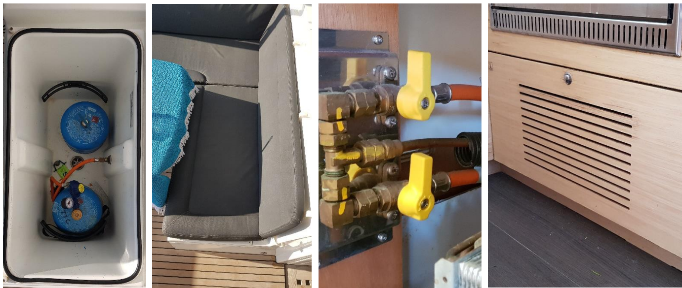
Zdjęcie 20. Butla z gazem kuchennym (+ zapas) oraz odcięcie gazu kuchennego i ich umiejscowienie.
