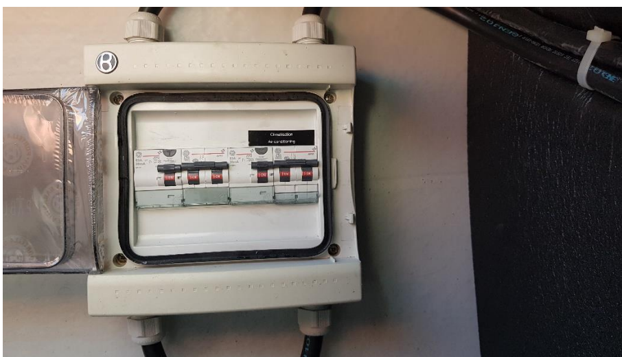
Zdjęcie 38. Przełącznik zbiorników paliwa i bezpieczniki generatora
