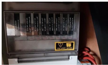
Zdjęcie 24. Pod prawą koją rufową: bezpieczniki od kotwicy oraz dodatkowo heble od odłączania akumulatorów serwisowego i prawego silnika. Za panelem 12/220V w salonie: bezpieczniki 12V (czerwone) i główne (szara skrzynka) instalacji 220V.
