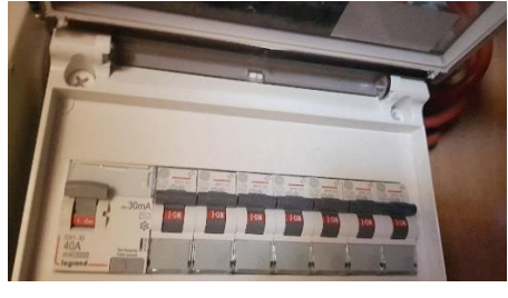
Zdjęcie 25. W szafce w prawej kabinie rufowej bezpieczniki od lewej: w pierwszej puszcze: generator, odsalarka, zmywarka, wolny (opisany jako kostkarka do lodu), w prawej puszcze: różne strefy klimatyzacji. Poniżej puszek (żółty przełącznik) – kabestan elektryczny.
