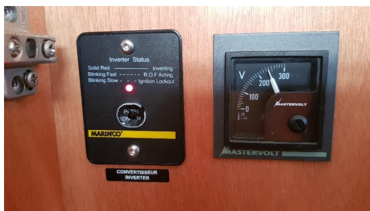
Zdjęcie 19. Włączony wbudowany inwerter na elektrycznej tablicy rozdzielczej.
