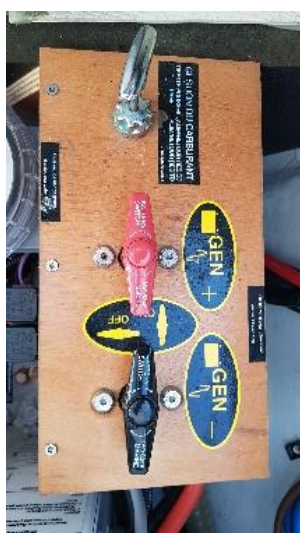
Zdjęcie 38. Przełącznik zbiorników paliwa i bezpieczniki generatora
